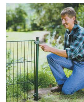
Sind die Zaunelemente dann fertig ausgerichtet, können Sie die Schellschrauben fest anziehen.
