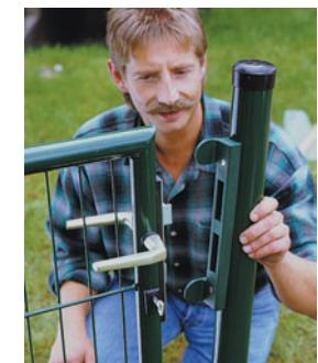
Auf dem zweiten Torpfosten bringen Sie zunächst den Toranschlag an.
