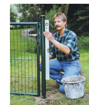
...betonieren ihn ein und richten ihn ebenfalls mit der Wasserwaage aus.
