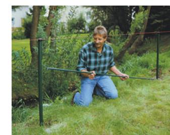
Der Abstand von Zaunpfahl zu Zaunpfahl beträgt ca. 2040 mm (lichtes Maß zwischen den Pfählen). Eine große Arbeits erleichterung und hohe Genauigkeit bietet hier der Einsatz der Montagehilfe.
