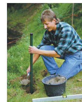
Stecken Sie den Zaunpfahl in das vorbereitete Fundamentloch und füllen dieses mit Beton auf.
