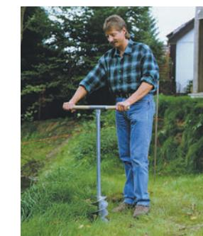
Heben Sie nun das erste Fundamentloch aus (Tiefe je nach Zaunpfahllänge, mind. aber 400 mm). Es empfiehlt sich der Einsatz eines Bodenbohrers. Sie sparen Zeit und Kraft, viel Beton und schonen die Umwelt. Bodenbohrer gibt es für verschiedene Bohrlochdurchmesser.
