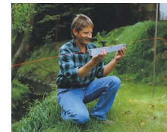
Nachdem Sie den Verlauf Ihres Zaunes festgelegt haben, ziehen Sie zunächst eine Richtschnur in Höhe Oberkante Zaunpfähle und richten diese mit der Wasserwaage aus.
