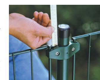
Wenn alle Zaunpfähle einbetoniert sind und der Beton ganz abgebunden hat, können Sie die Schellen vormontieren. Das Maß von Oberkante Zaunpfahl bis Oberkante Zaunelement beträgt ca. 50 mm.
