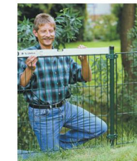
Die eingesetzten Zaunelemente können Sie dann mit der Wasserwaage ausrichten.
