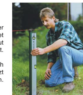
Nachdem Sie den Pfosten mit einer Wasserwaage genau ausgerichtet haben, stampfen Sie den Beton gut fest.
