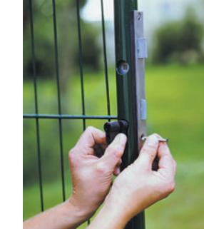
Jetzt kann das Rohrrahmen-schloß eingesetzt und festgeschraubt werden.
